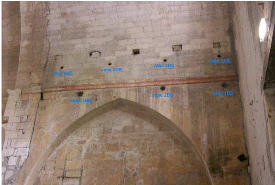
Localisation des vases acoustiques dans la première travée de l'église Saint-Blaise, sur le mur sud.
